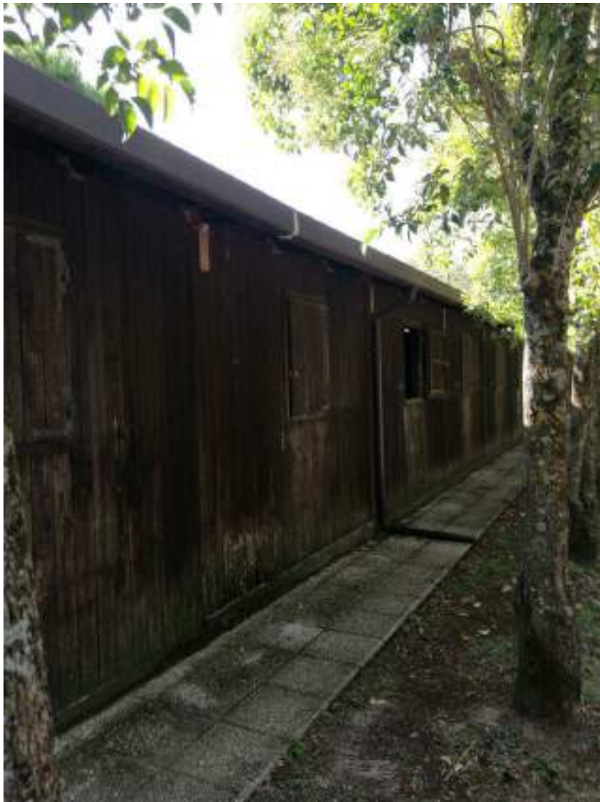
Scorcio della stalla lato ovest
