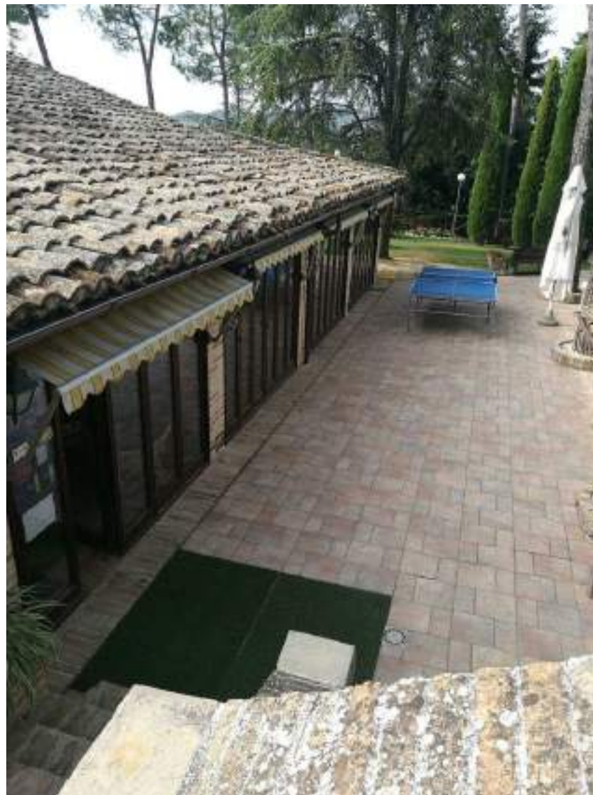
Vista del lato ovest della veranda (edificio uno)
