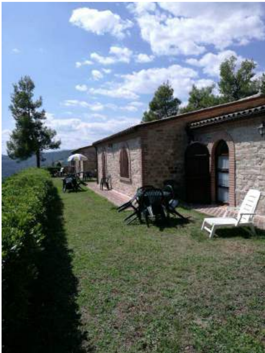
Scorcio del lato est lotto 4 vista da nord
