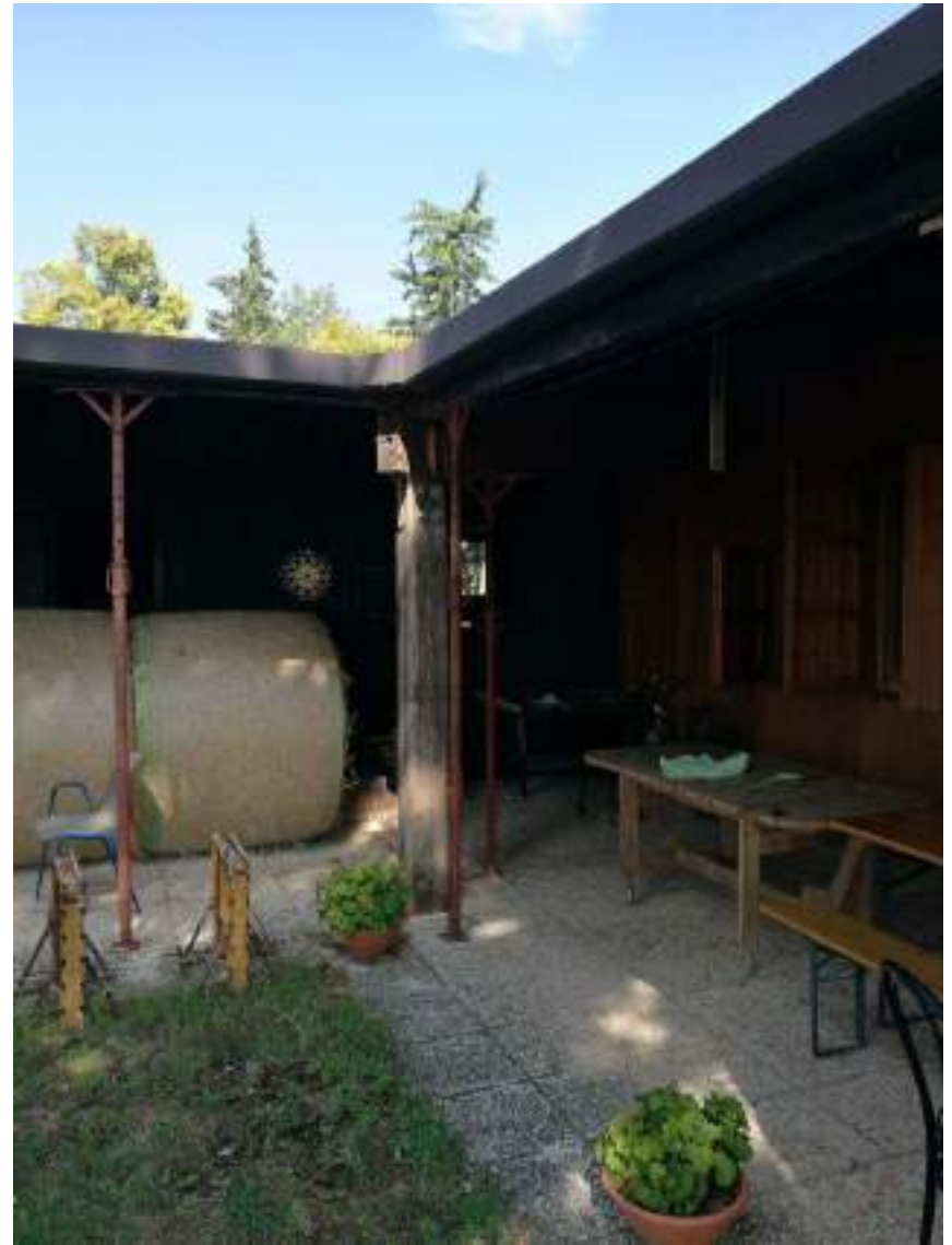
Vista dell'angolo porticato da sud
