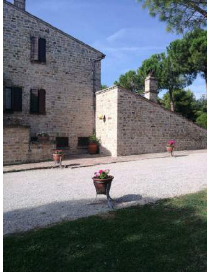
Facciata nord hotel ristorante edificio uno (lato dx)
