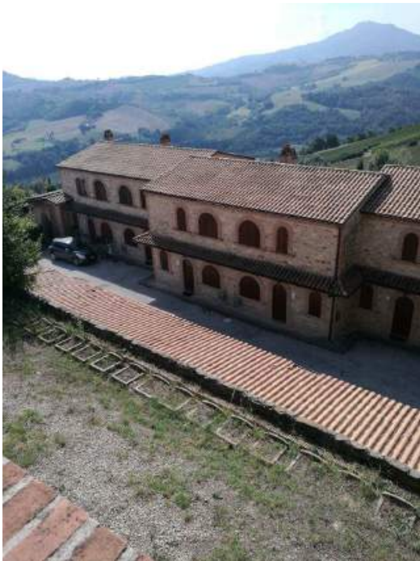
Vista dall'alto del lotto 5 da nord lato sx
