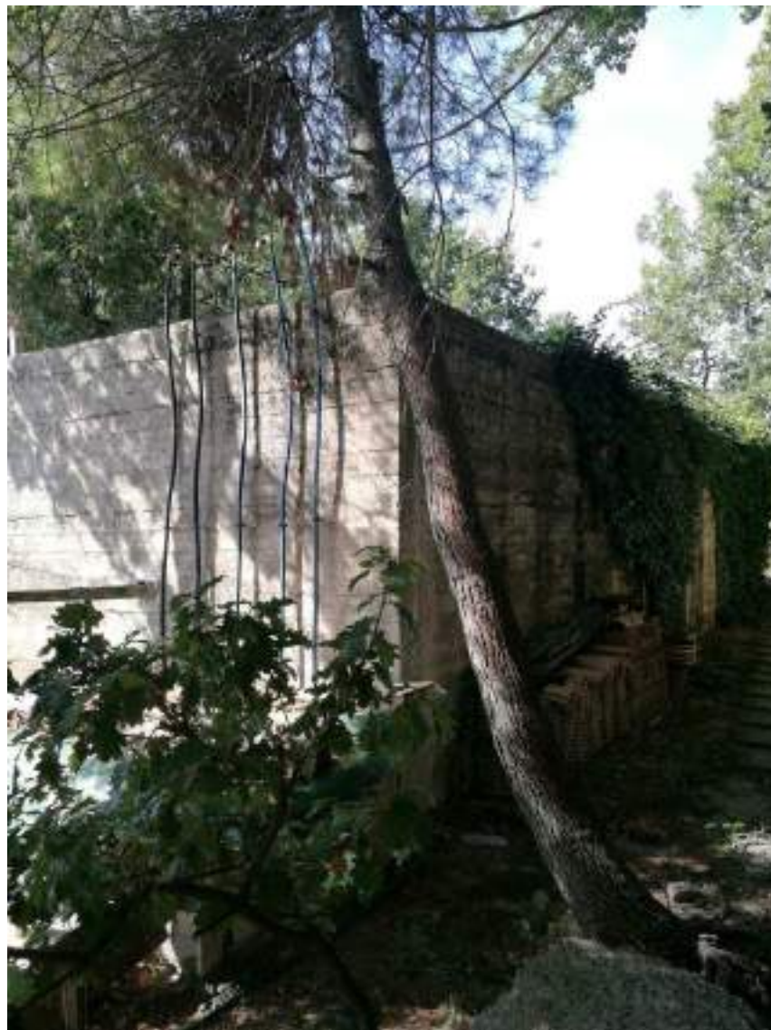
Lotto 7 – Vista del serbatoio idrico
