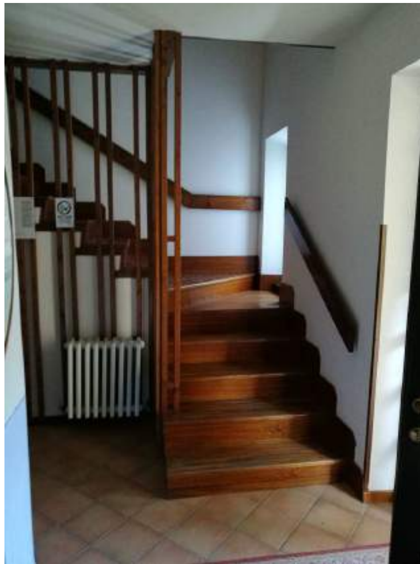
Vano scale interno (edificio uno)
