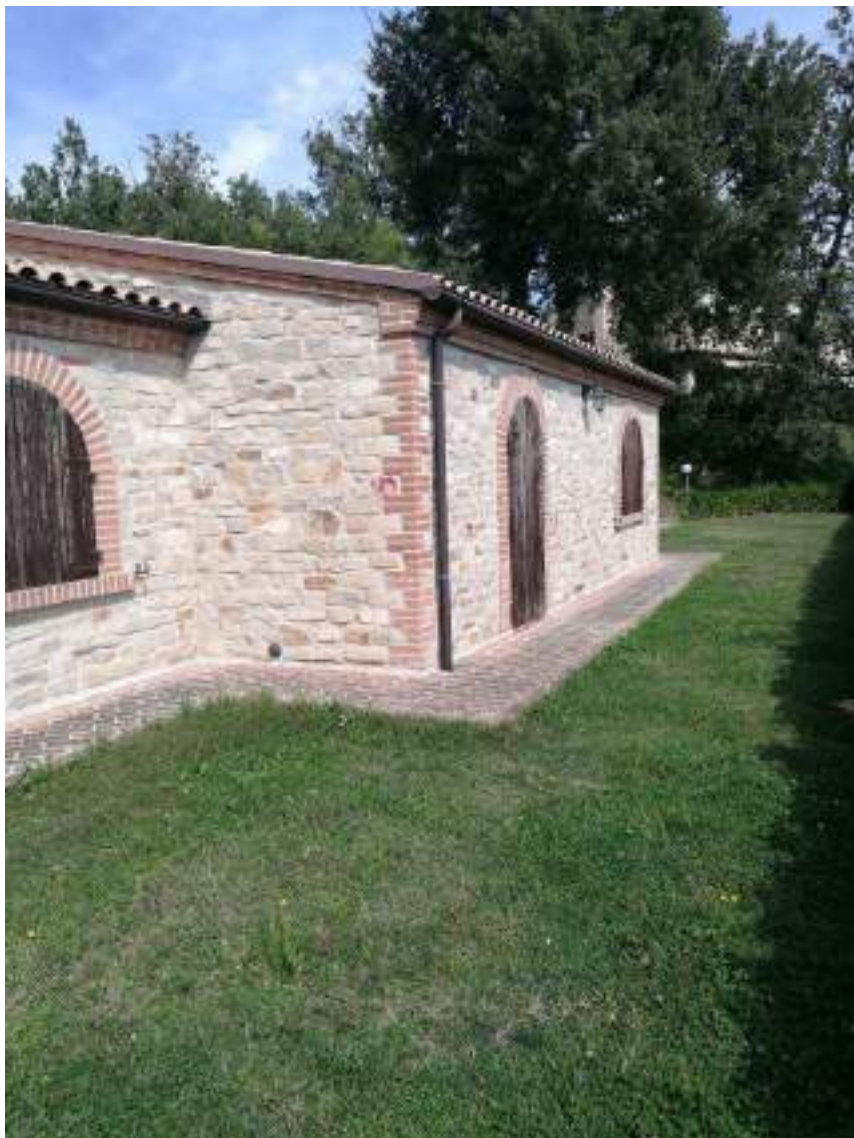
Scorcio lato est lotto lotto 3.C
