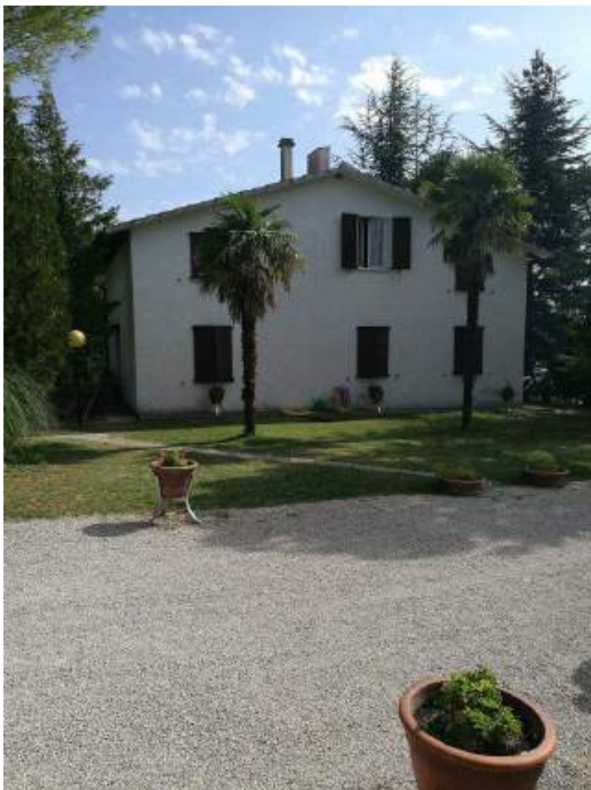
Vista del lato sud (edificio due)
