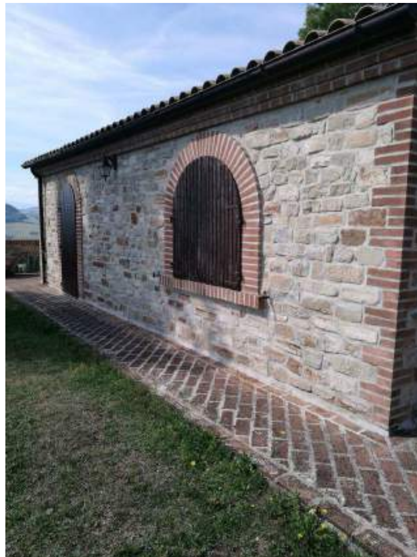
Scorcio lato est lotto lotto 3.D
