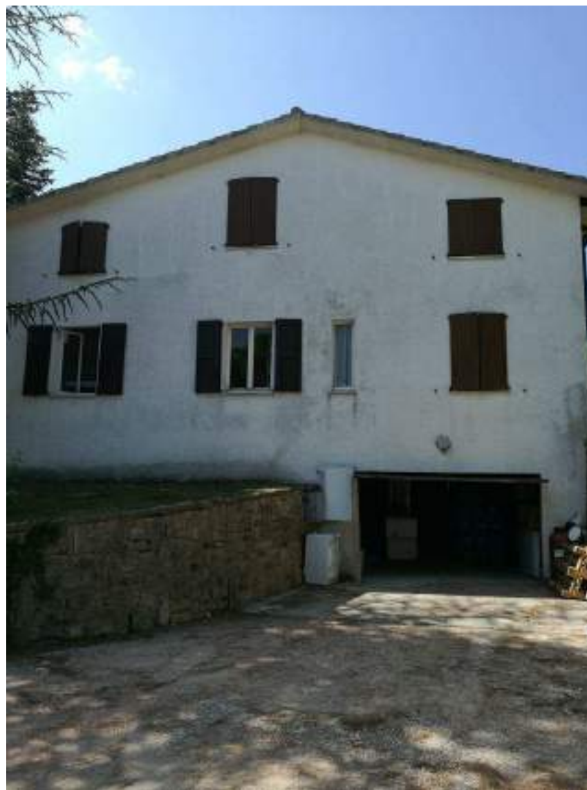
Vista del lato nord (edificio due)
