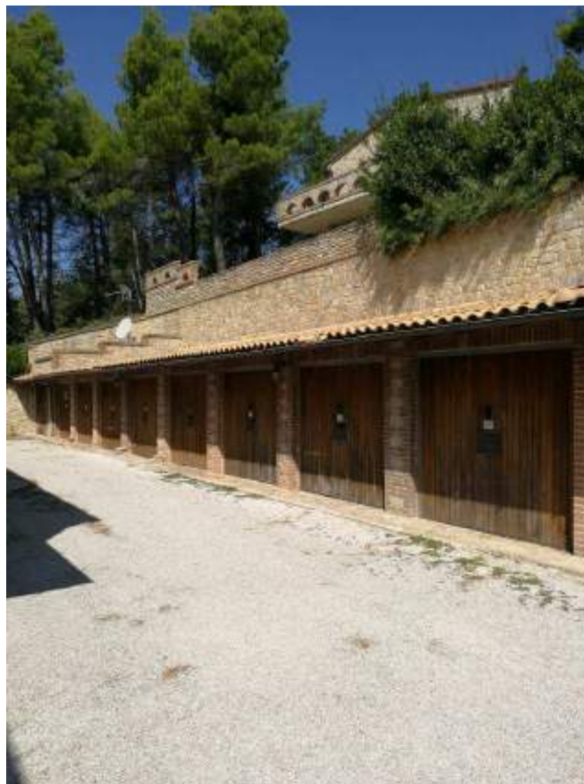
Scorcio dei box auto visti da sud est
