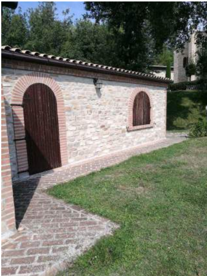
Scorcio lato est lotto 3.A
