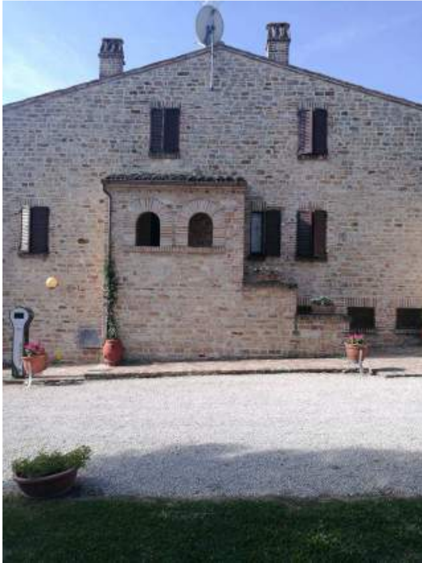
Facciata nord hotel ristorante edificio uno (accesso alle camere)
